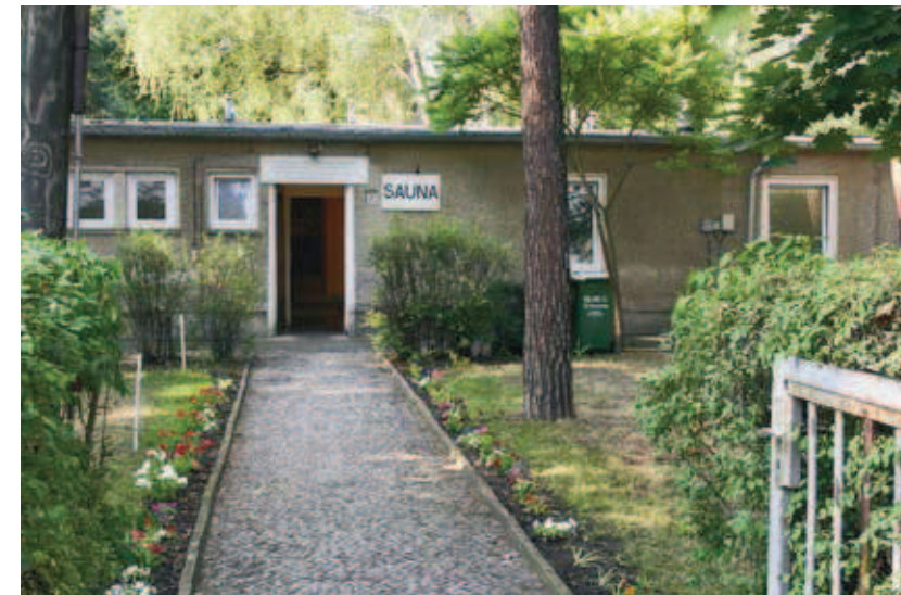
Ehemalige Unterakunftsbaracke, die bis heute als Sauna genutzt wird, 2008
