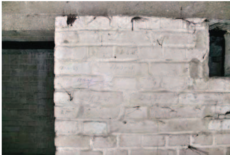
Inschriften von italienischen Zwangsarbeitern im Keller der Baracke 13, 2007
