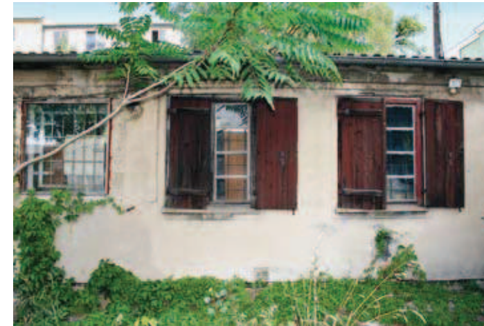
Baracke 13 mit Originalfenstern und -fensterläden, 2008
